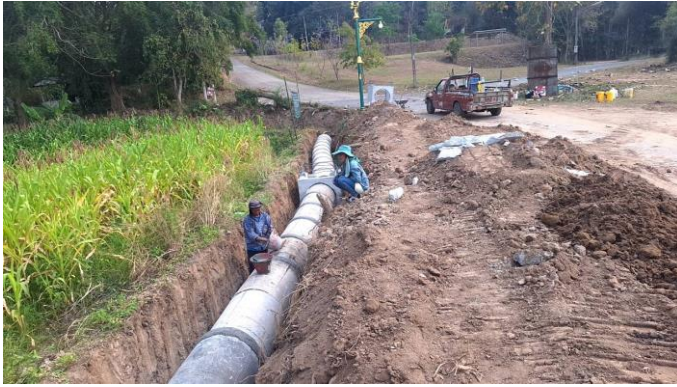
ภาพโครงการวางท่อระบายน้ำ คสล. พร้อมบ่อพัก คสล. หมู่ที่ ๒ บ้านจอมจันทร์
